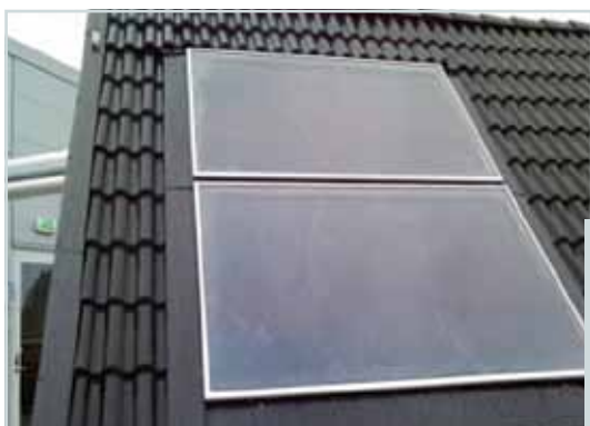
Système de chauffe-eau solaire : deux exemples d'installation à petite échelle (deux à trois capteurs).
