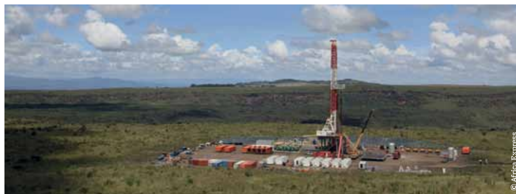
Plateforme de forage d'un puits à la centrale géothermique de Menengai au Kenya.
