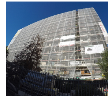
Résidence Vouillé- Brancion Paris (75) Travaux
