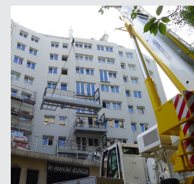
POSE DES BALCONS
