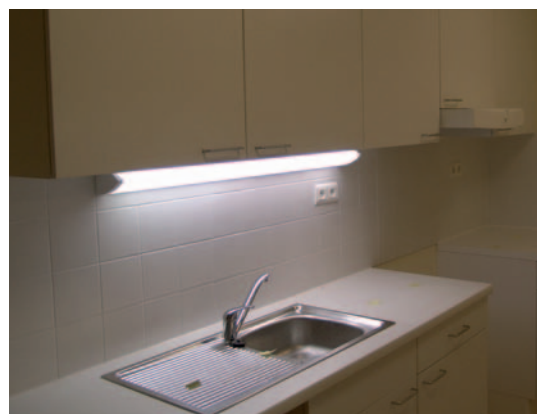
Fig. 56 Réglette murale fixée sous les armoires suspendues.
