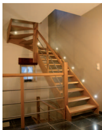
Fig. 33 Luminaires de décoration et de balisage utilisant des LED.
