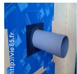
✓ Dans le cas d'un isolant en vrac, il est bon de **faire passer l'électricien après la pose de la membrane étanche** (quand celle-ci fait office de « caisson ») mais avant l'insufflation de l'isolant en vrac, la membrane sera plus résistante avec les gaines posées.
